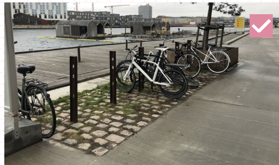
29 Dláždený nestmelený povrch pod cyklostojanmi zvyrazňuje jeho odlišnú funkciu a zároveň prepúšťa vodu. Dánsko, Kodaň
