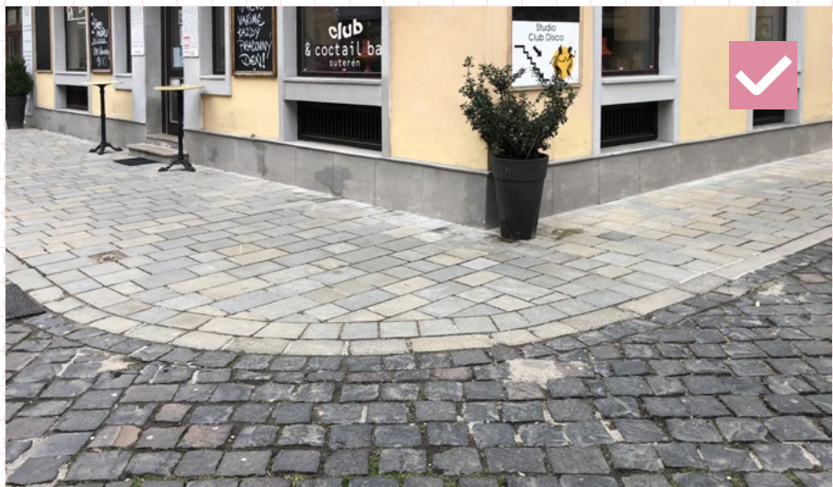
38 Úsek dlažby ukončený zároveň s fasádou zvyrazňujúc hierarchiu ťahov/ nadradenosť chodníka. Bratislava, Laurinská
