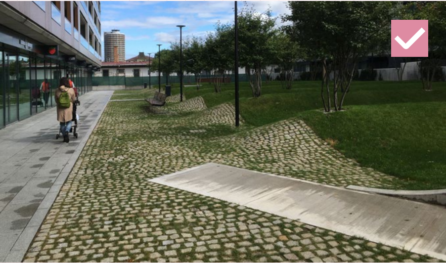
56 Dlažobnú kocku je vhodné použiť aj na vytvorenie vodopriepustného zatravněného povrchu. Bratislava, Račianska
