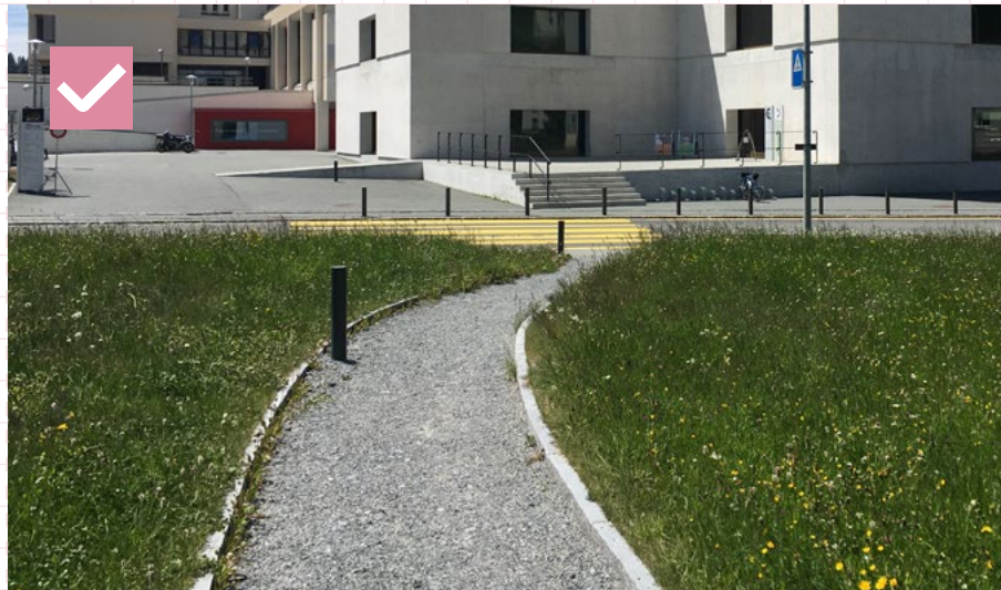
74 Chodník z vibrovaného štrku s kamenným obrubníkom. Svajčiarsko, Zerez
