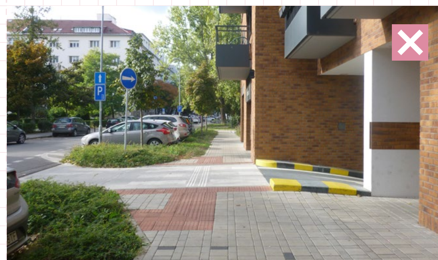
66 Narušená kontinuita chodníka znížením jeho úrovne, nadradením prejazdu pre vozidlá do obytnej budovy a použitím hmatateľných povrchov červenej farby. Bratislava, Steinov dvor
