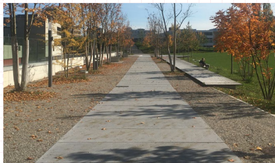
12 Betónový chodník s pravidelným škárovaním. Švajčiarsko, Bazilej
