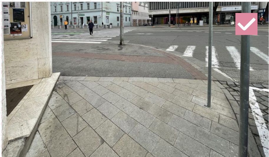
39 Dlážděný chodník oddelený od asfaltového radom dlažbových plátň uložených rovnobežne s rozhraním. Bratislava, Námestie SNP
