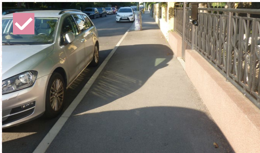
67 Chodník s povrchom z asfaltobetónu s betónovým obrubníkom. Bratislava, Včelárska
