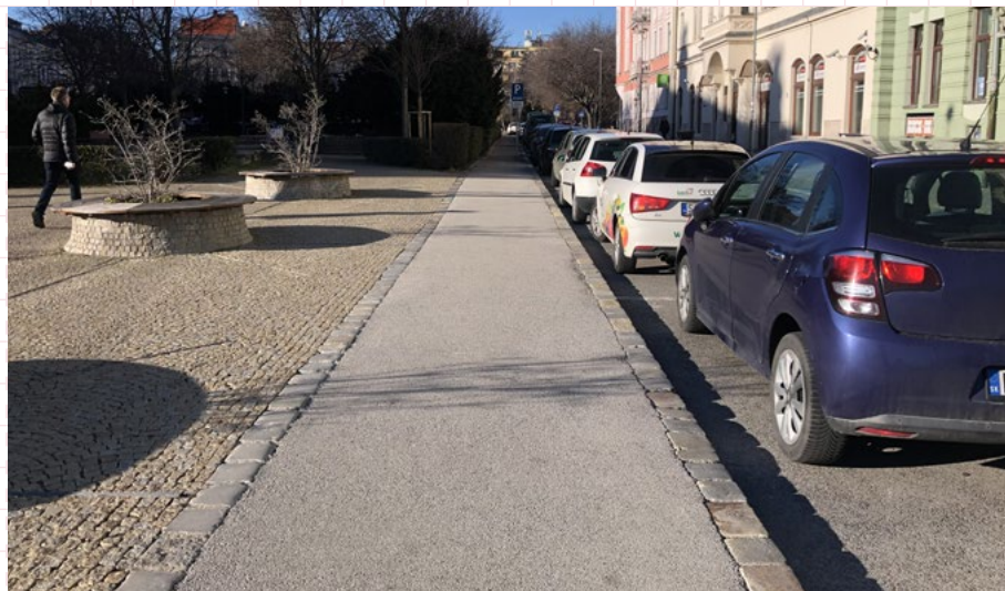
07 Asfaltový chodník s kamenným krajkom a obrubníkom. Bratislava, Safárikovo námestie
