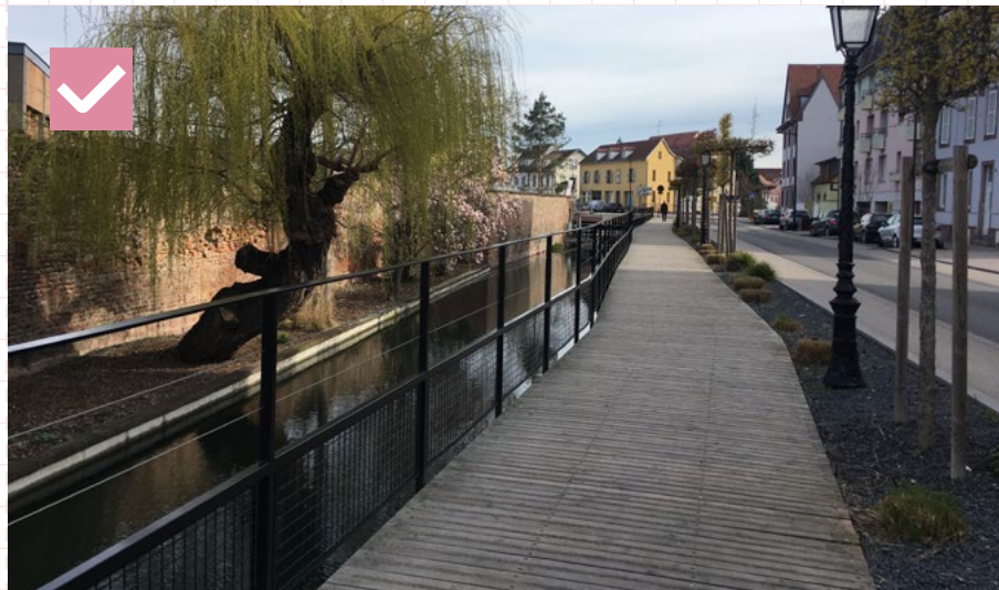
75 Chodník z drevených lát so špeciálnym detailom zabezpečujúcim protišmykovosť. Francúzsko, Colmar
