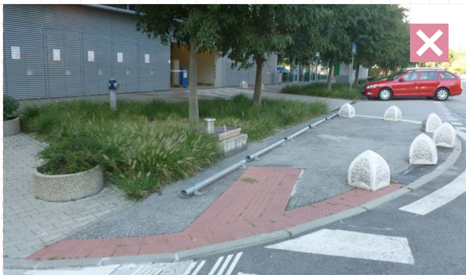
52 Nevhodné vyhotovenie hmatateľného povrchu červenou farbou, signálny pás navádza na chodník s fyzickými prekážkami a bez pokračovania, je dôležité nasmerovanie na smer, ktorý je pre nevidiacich žiadúci. Bratislava, Jarabinková
