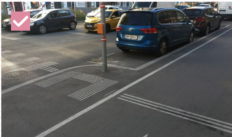
48 Hmatateľný povrch z indikátorov zo studeného plastu. Rakúsko, Viedeň
