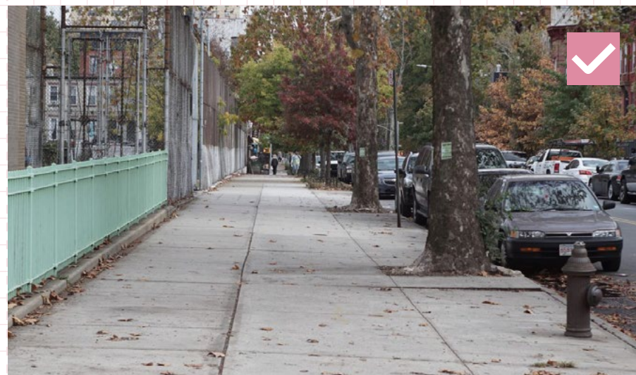
70 Betónový chodník s pravidelným škárováním. Spojené štáty, New York
