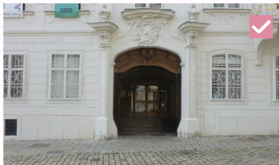
81 Zachovaná kontinuita chodníka, vstup (pravdepodobne historický vjazd) naznačený kolmým kladením rovnakej dlažby. Bratislava, Františkánske námestie
