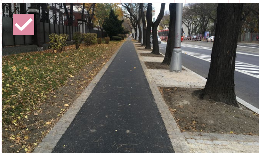
69 Chodník s povrchom z asfaltobetónu s rozhraniami z kamennej dlažobnej kocky. Bratislava, Vajnorská
