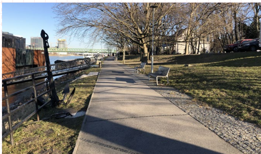
08 Asfaltový povrch so segmentami predelenými malou kamennou dlažbovou kockou. Bratislava, Promenáda pri Dunaji
