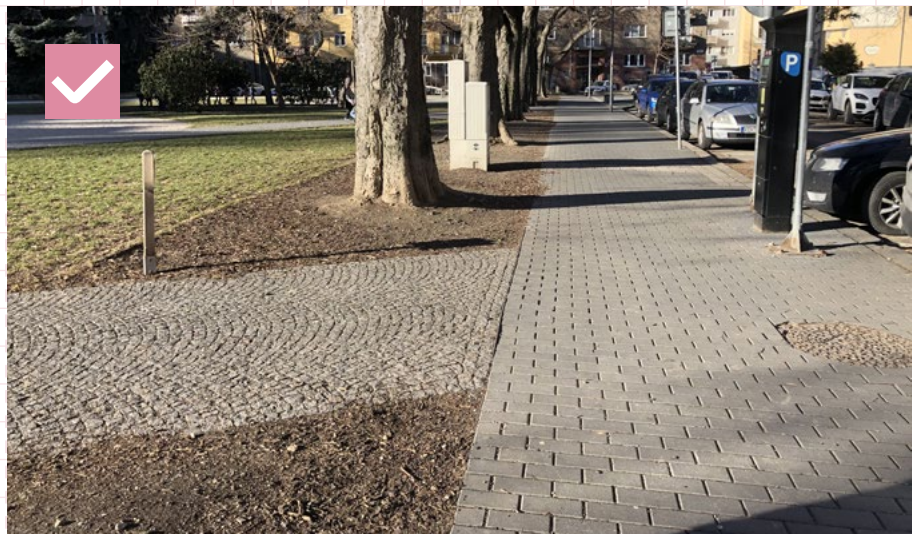
36 Šikmý styk dlážděných povrchov s rozhraním z ocelevej pásoviny. Bratislava, Landererov park
