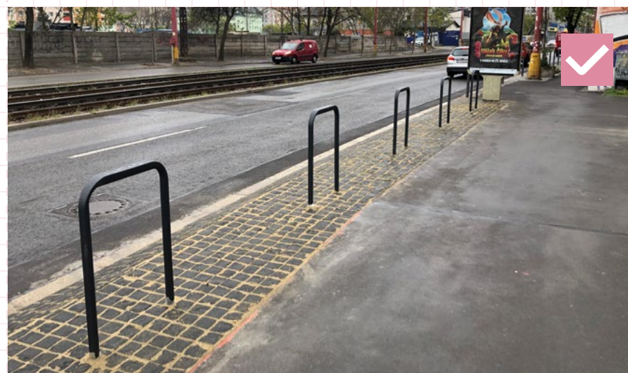
35 Okolo pozdĺžne radených cyklostojanov na chodníku je vydláždená ich celá manipulačná plocha až po rozhranie chodníka. Bratislava, Račianska
