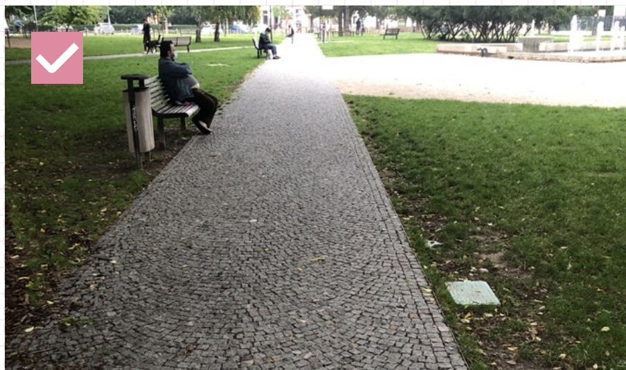
76 Dláždzený chodník s rozhraním z ocelej pásoviny. Bratislava, Landererov park
