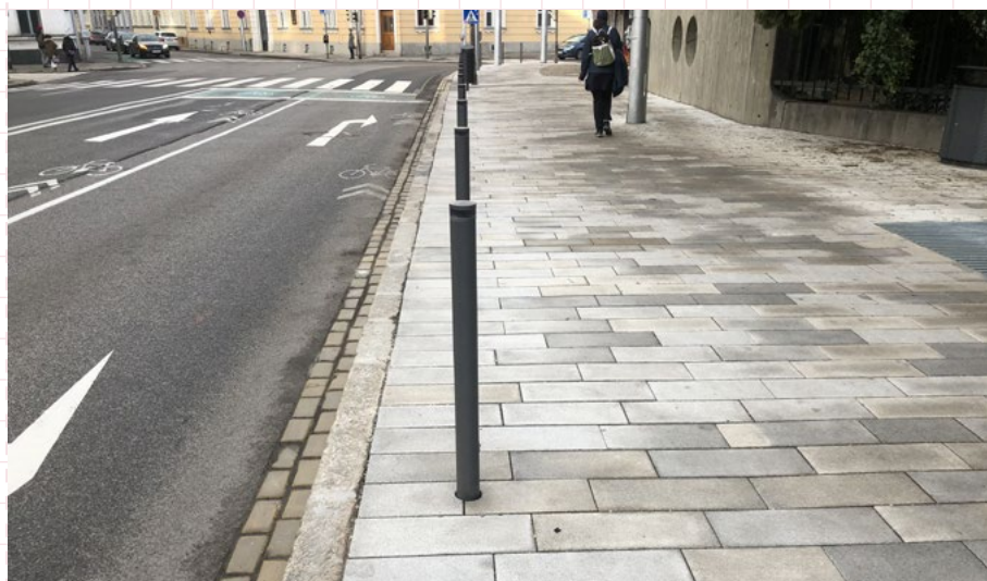
02 Povrch zo žulovej platne s kamenným obrubníkom a s prídlažbou z keramitu. Mlynské nivy
