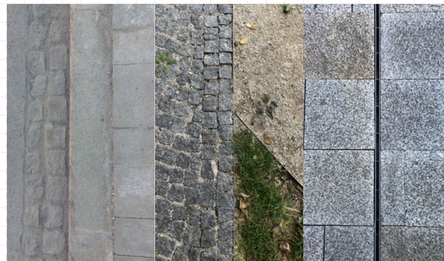
Zľava Kamenný obrubník oceľový obrubník štrbinový žlab.
