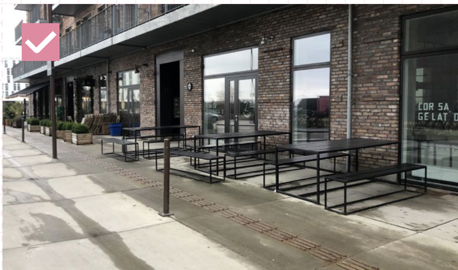
49 Hmatateľné prvky z cortenu, umelá vodiaca línia paralelná s fasádou naviguje nevidiaceho po bezpečnej trase a pri fasáde je ponechaný priestor pre terasové sedenie, ktoré netvorí bariéru. Dánsko, Kodaň
