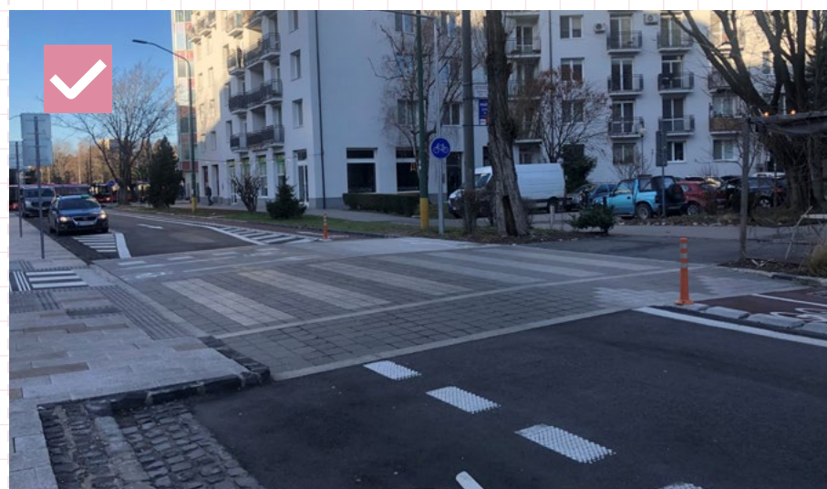
63 Priechod pre chodcov, ktorý je súčasťou spomaľovacieho prahu je možné vyhotoviť z farebne kontrastných dlažbových prvkov. Bratislava, Páříčkova ulica
