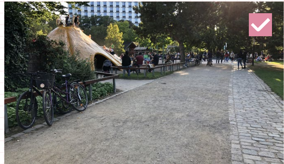
78 Kombinácia dláždzeného a mlatového povrchu s rozhraniami z kameňa po oboch stranách chodníka. Nemecko, Hamburg
