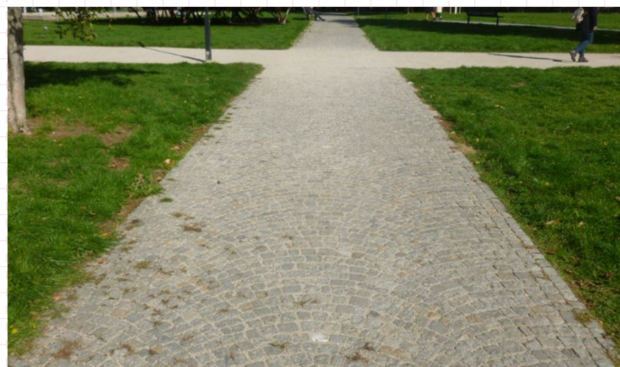
06 Povrch z kamennej dlažobnej kocky s vejárovitým kladením s ocelovým obrubníkom. Bratislava, Landererov park
