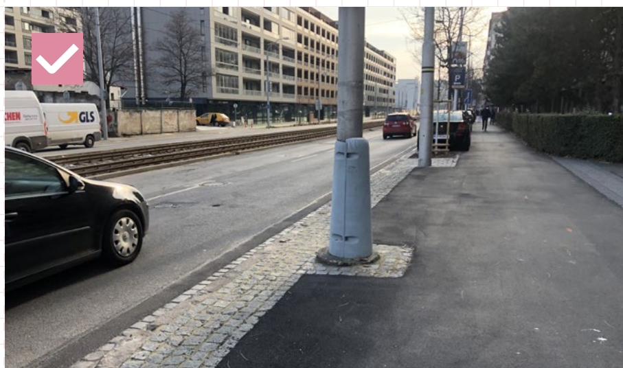
28 Bodové lemovanie okolo prvkov technickej infraštruktúry je spojené s pásom lemovania pri vozovke. Bratislava, Račianska
